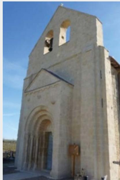
Ces travaux se sont réalisés en 2 phases : La première phase consistait à purger les murs insalubres de leur crépi afin d'enlever l'humidité intérieure qui se faisait par capillarité. Cette opération a été réalisée en 2022. La deuxième phase de réhabilitation se fera en 2024.
